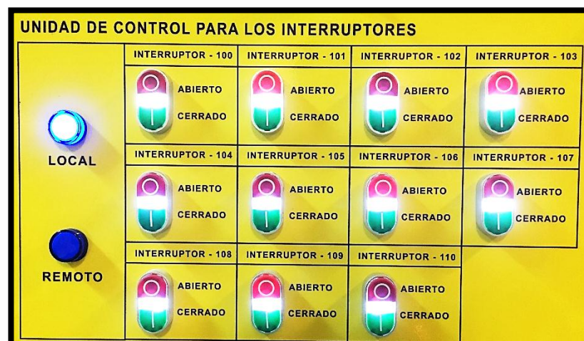
FIGURA 62: UNIDAD DE CONTROL PARA INTERRUPTORES FUENTE: LOS AUTORES.
