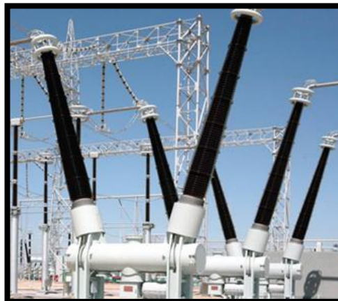
FIGURA 52: INTERRUPTOR DE POTENCIA AISLADO EN SF6. FUENTE: [7].
