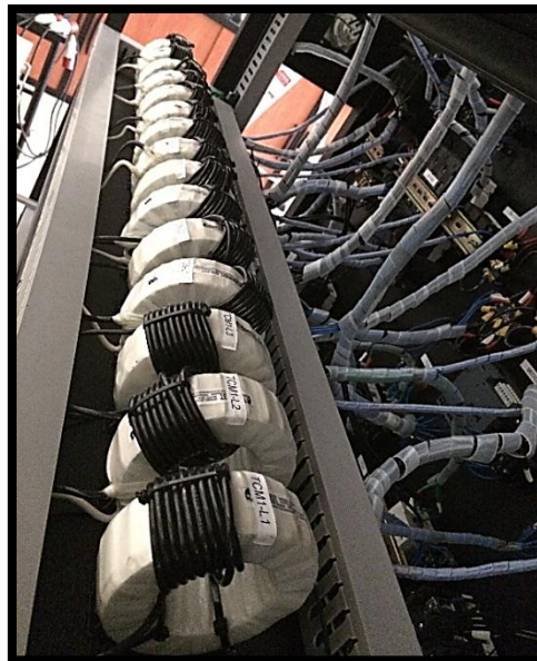
FIGURA 34: CONEXIONES Y CABLEADO VISTA 1. FUENTE: LOS AUTORES
