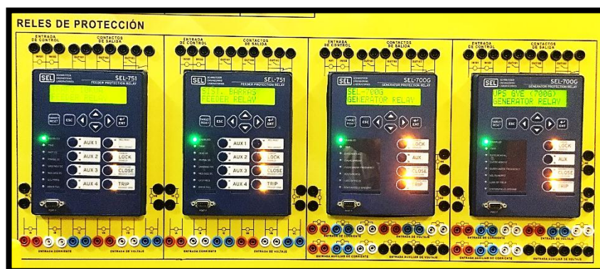
FIGURA 63: BLOQUE DE RELÉS DE PROTECCIÓN. FUENTE: LOS AUTORES.
