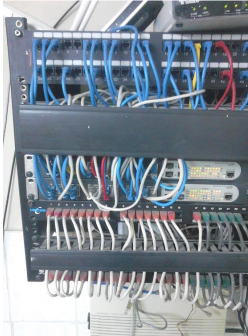
Ilustración 100 INFRAESTRUCTURA ANTES DE INTERVENCIÓN
