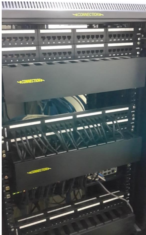
Ilustración 103 RACK ACTUAL ESTADO
