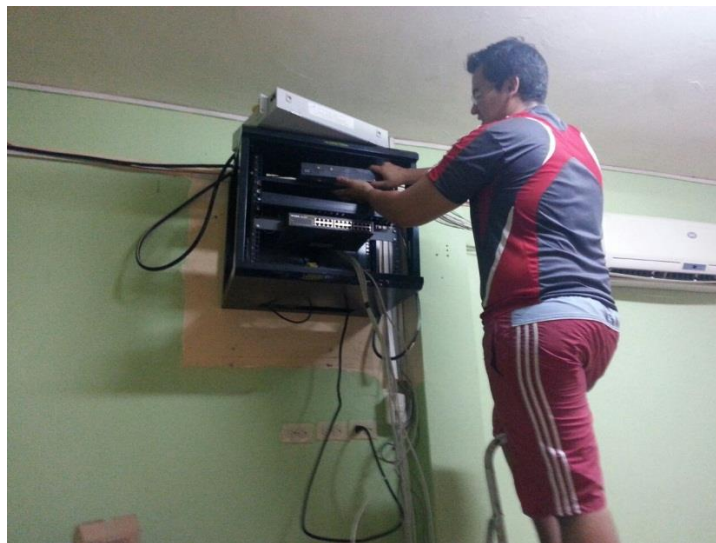
Figura 77, Colocación de equipos en el rack.
