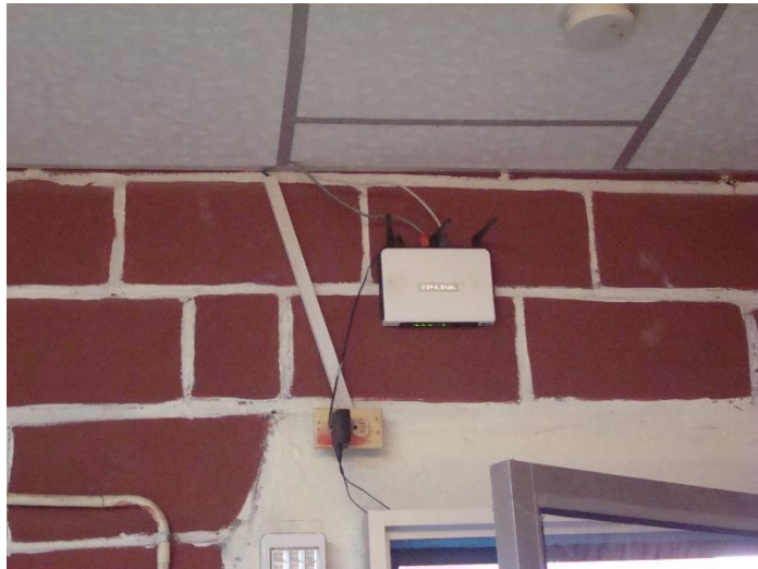
Figura 21, Access point del laboratorio 3ro de bachillerato
