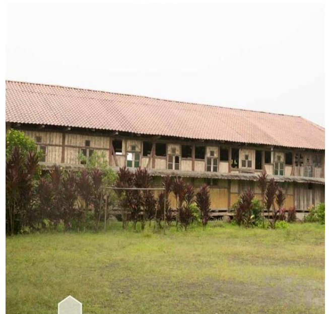
Instalaciones exteriores del internado de hombres en Sevilla Don Bosco, Macas
