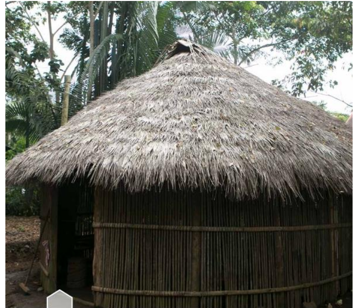
Cubierta de la casa Shuar, realizada con hojas de palma.
