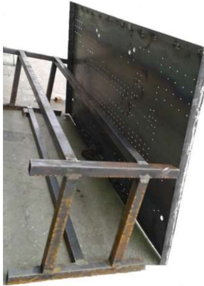
Figura 37. Calados y perforaciones en la plancha metálica
