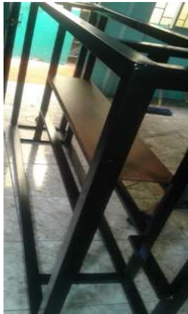
Figura 33. Construcción de la estructura metálica
