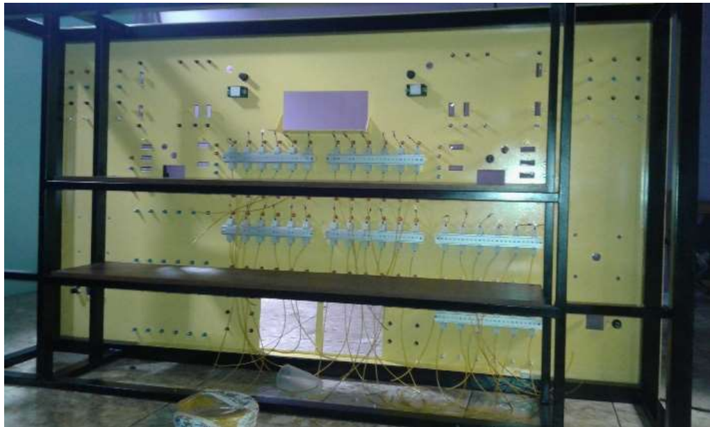
Figura 43. Montaje de equipos y elementos. Vista posterior
