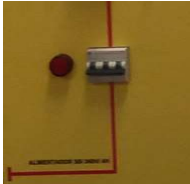
Figura 46. Disyuntor trifásico de 3P-10A -1
