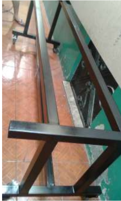
Figura 34. Construcción de la estructura de la mesa
