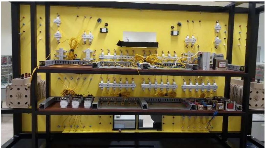
Figura 45. Cableado del tablero
