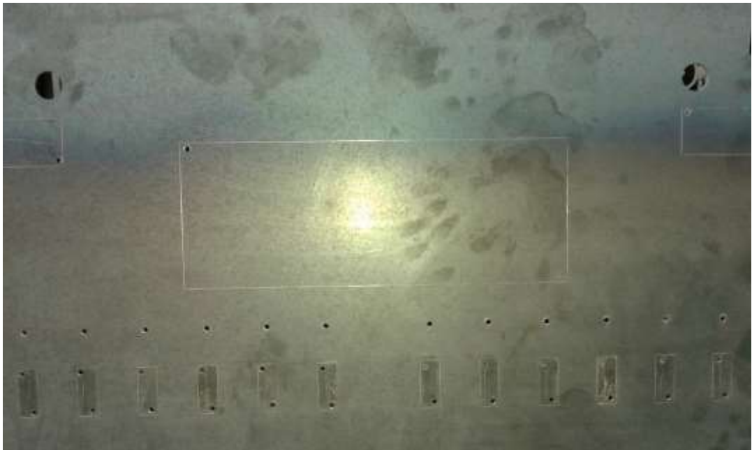
Figura 36. Calados y perforaciones luces piloto, portafusibles, y osciloscopio
