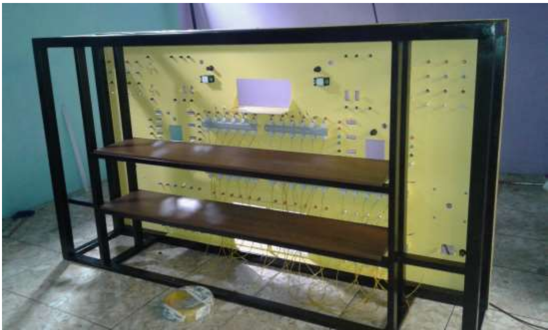
Figura 42. Montaje de las borneras, medidor DC y los portafusibles
