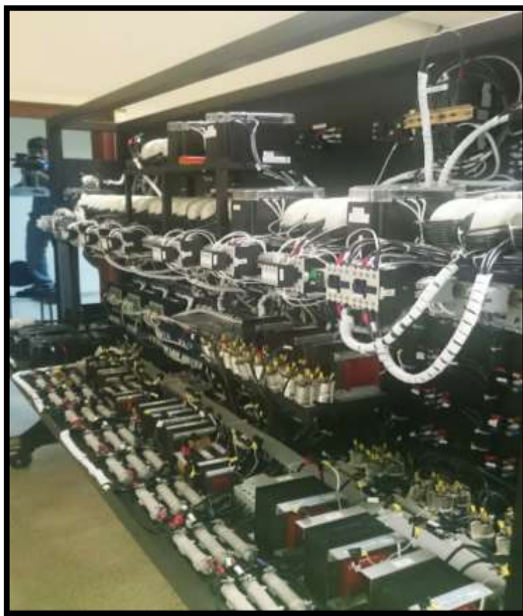
FIGURA 73 FINALIZACIÓN DE CABLEADO DE FUERZA Y CONTROL, FUENTE: LOS AUTORES.
