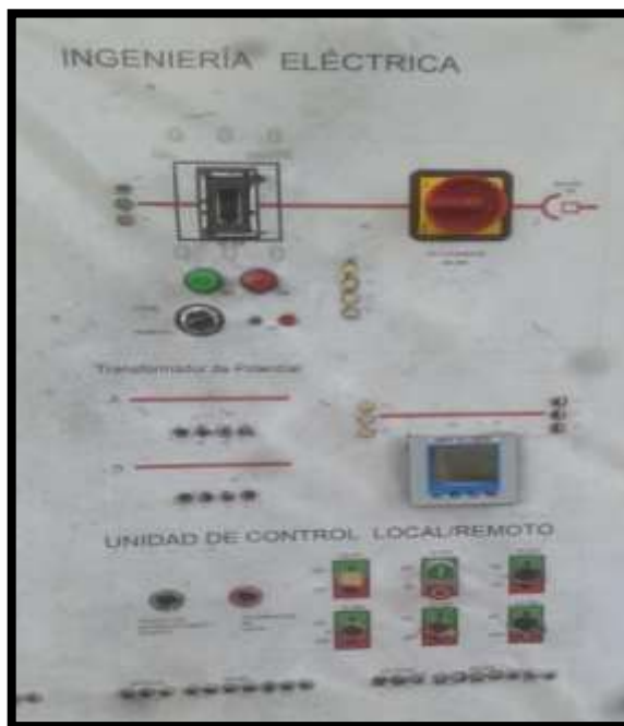
FIGURA 61 PRUEBA DE CALADO EN EL TABLERO, FUENTE: LOS AUTORES.
