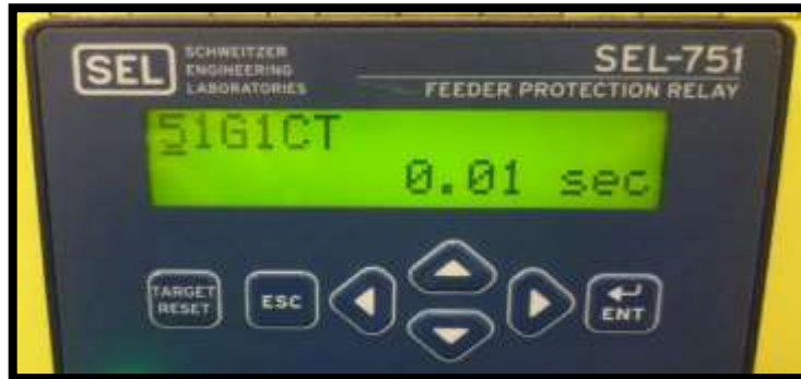
FIGURA 90 CONFIGURACIÓN DE DISPARO 51GT, FUENTE: LOS AUTORES.
