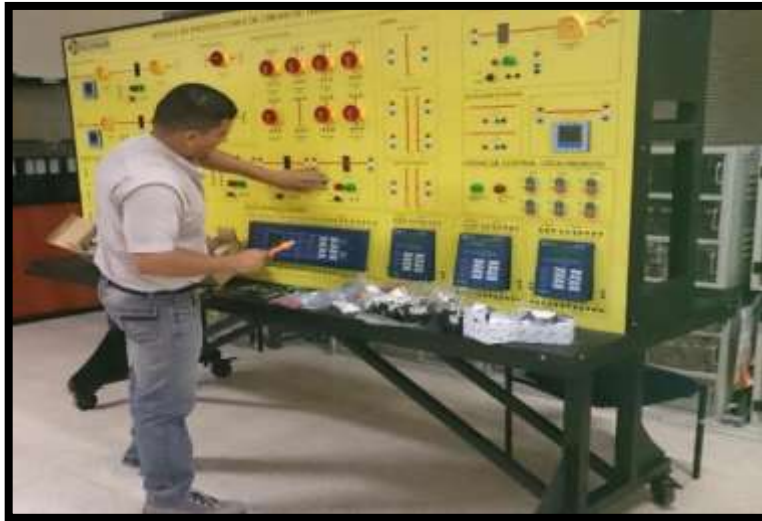
FIGURA 68 COLOCANDO LOS ELEMENTOS EN EL TABLERO, FUENTE: LOS AUTORES.
