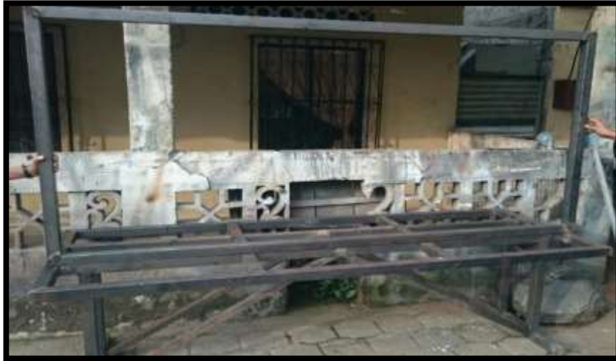
FIGURA 59 FABRICACIÓN DE LA MESA Y BASES DEL TABLERO, FUENTE: LOS AUTORES.
