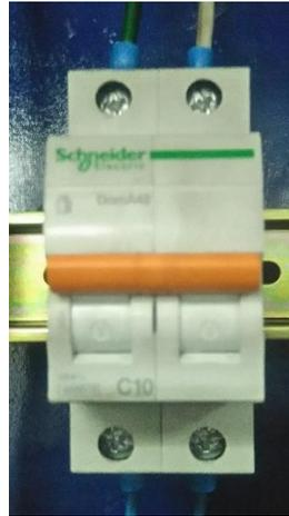
Figura 28. Disyuntor bifásico Schneider 10 A
