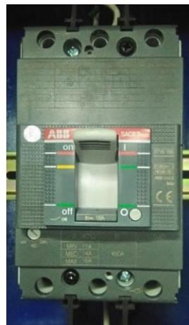
Figura 27. Disyuntor ABB Tmax trifásico 16 A
