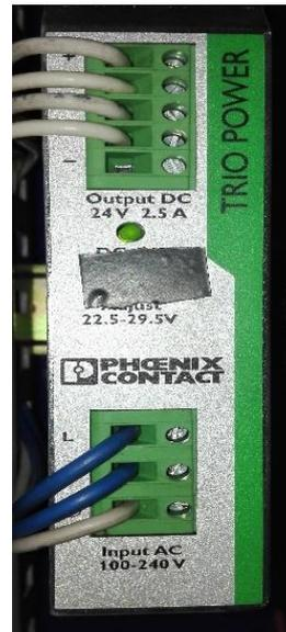
Figura 26. Fuente de voltaje Phoenix Contact 24 V DC
