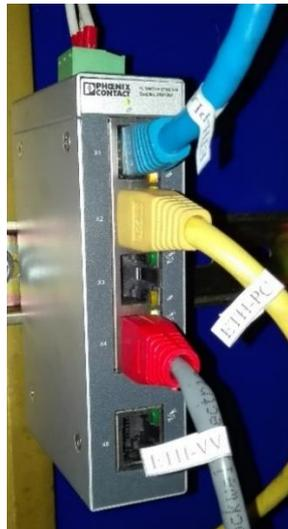
Figura 25. Switch industrial de 5 puertos ethernet
