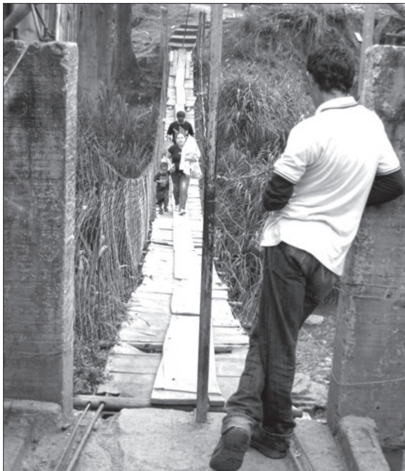
Fotografía N° 6 Puente en su estado actual
