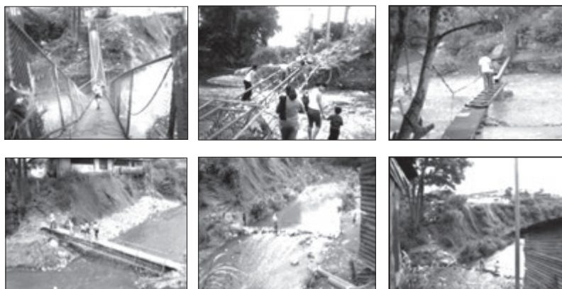
Fotografías N° 5 Problemática de la caída del puente en Barrio Nuevo, 2010- 2012
