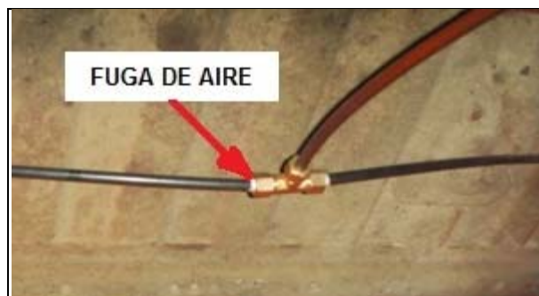
Fig. 4.46. Localización de fuga
