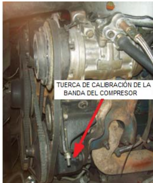
Fig. 4.38. Vista del compresor instalado en el recinto motor
