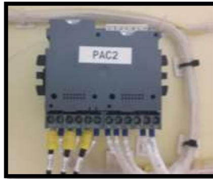
**Figura35:** Parte posterior del medidor de energía
