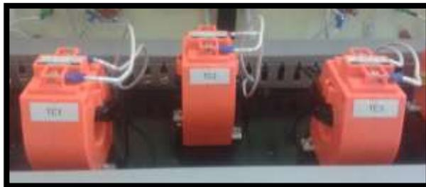
**Figura42:** Transformador de corriente
