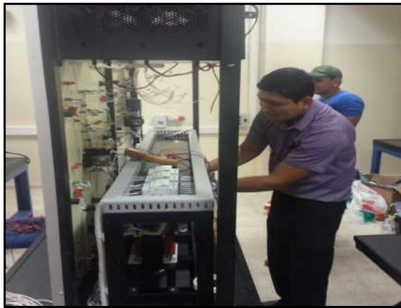
**Figura18:** Montaje de estructura de soporte de transformadores
