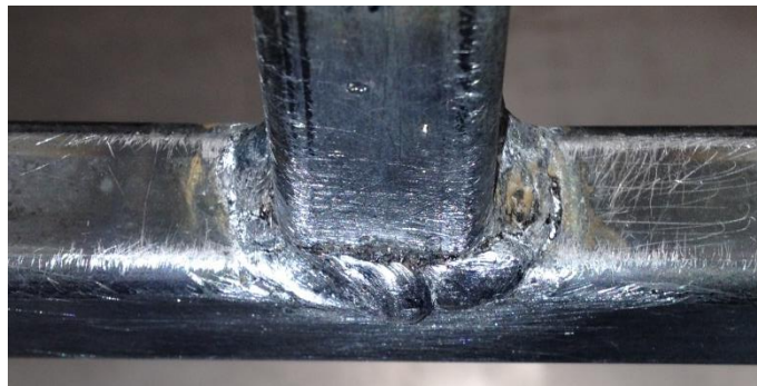
Figura 202 Cordón de Soldadura Luego de la Limpieza.
