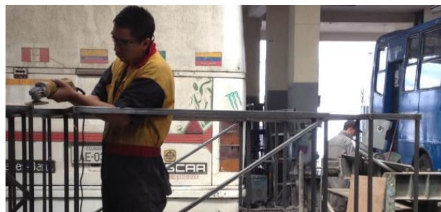
Figura 206 Esmerilado del Exceso del Cordón.
