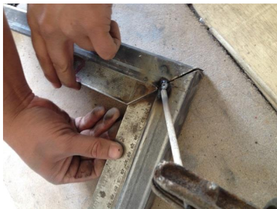
Figura 189 Comprobación de la Escuadra Previo al Punto de Suelda
