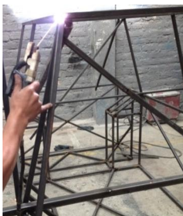
Figura 199 Unión de la Estructura Mediante Cordón de Soldadura
