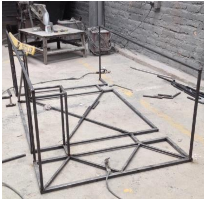
Figura 192 Armado de los costados de la estructura.
