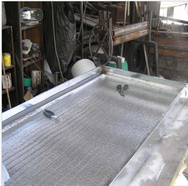
Fig. 19 Construcción de la caja metálica
