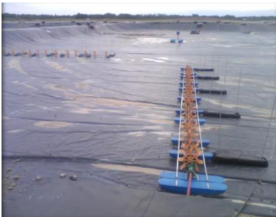
Figura 10: Montaje de Aireadores de piscinas camaroneras Fuente: Empresa J. SURATY M
