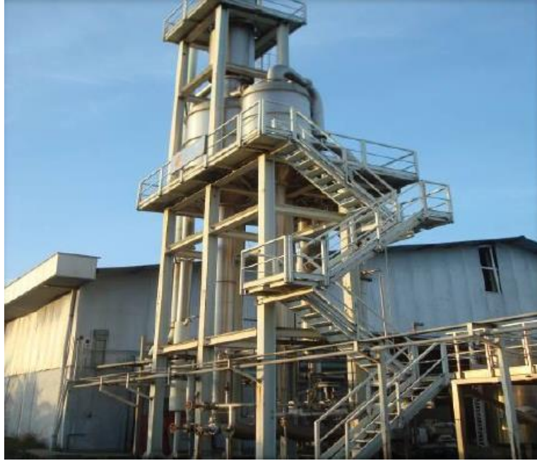
Figura 9: Mantenimiento General de Estructura, Construcción de Torres de Almacenamiento
