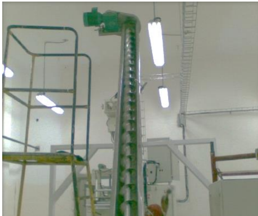
Figura 8: Transportador de Tornillo Fuente: Empresa J. SURATY M
