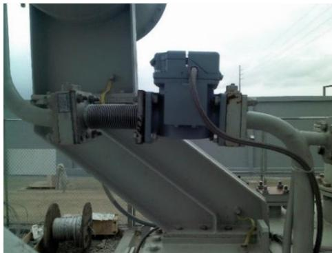
Figura No. II- 13 Relé Buchholz (Subestación SMI-Ecuador)
