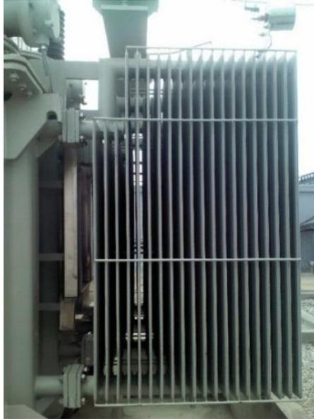
Figura No. II- 14 Radiador adherido al transformador (Subestación SMI-Ecuador)
