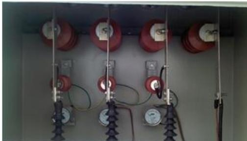
Figura No. II- 12 Bushings de salida de un transformador trifásico (Subestación SMI-Ecuador)
