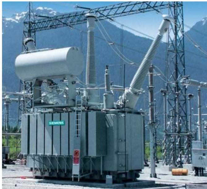
Figura No. II- 20 Transformador elevador de voltaje
