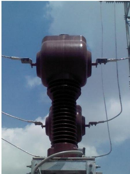
Figura No. II- 24 Transformador de corriente de 100/5 A (Subestación SMI-Ecuador)
