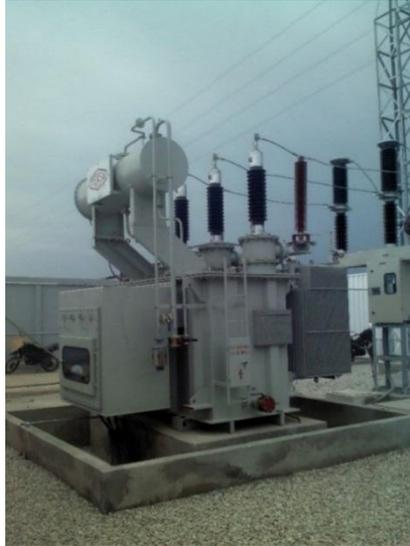
Figura No. II- 17 Transformador trifásico de 5 MVA (Subestación SMI-Ecuador)
