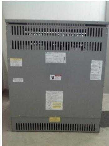
Figura No. II- 16 Transformador seco trifásico de 500 kVA (SMI-Ecuador)
