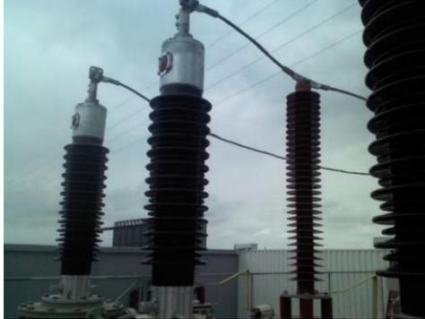
Figura No. II- 11 Bushings de entrada de un transformador trifásico (Subestación SMI-Ecuador)
