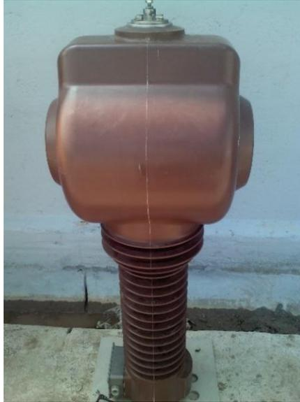
Figura No. II- 23 Transformador de potencial 69 kV/110 V (Subestación SMI-Ecuador)
