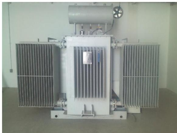
Figura No. II- 28 Transformador trifásico de 3 MVA (Subestación SMI-Ecuador)
