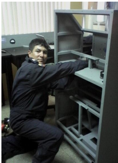
Figura 3.16 Montaje de los templadores.
