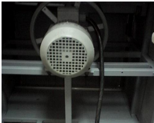
Figura 3.17 Montaje motor trifásico.
