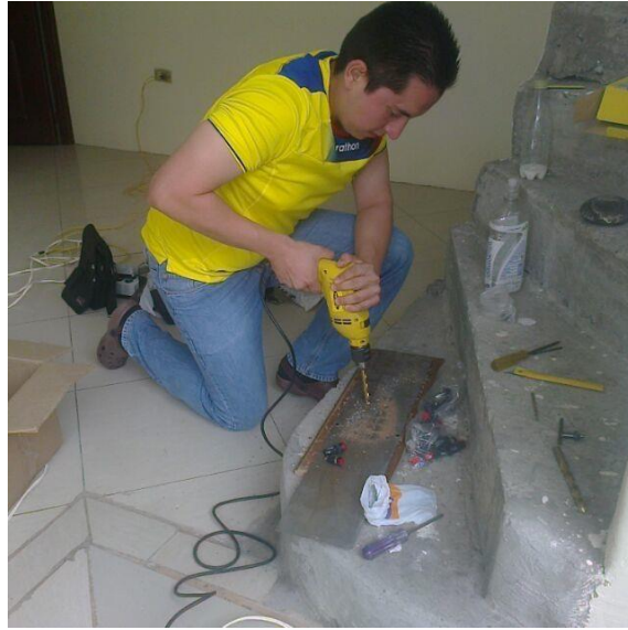
Figura 3-19 Elaboración de Huecos para colocación de Dispositivos
