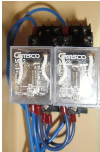
Figura 4-48 Relés internos del módulo para activación de sensores magnéticos conectados a borneras
