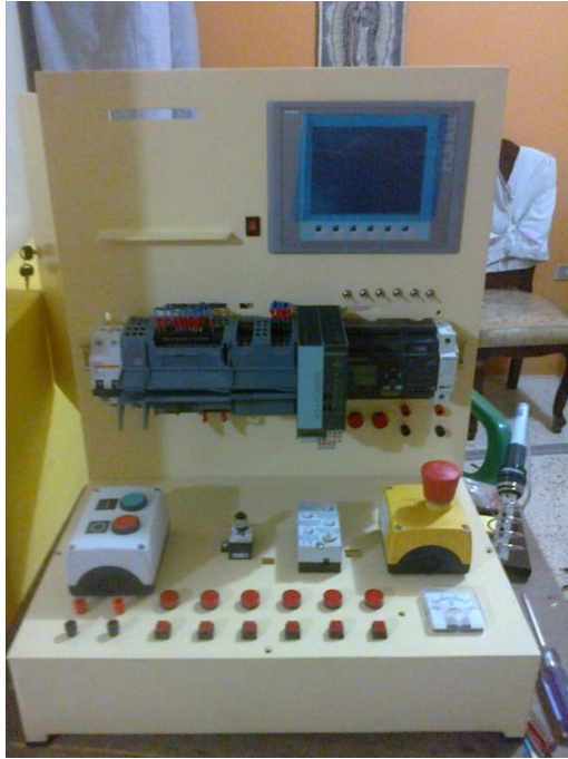
Figura 3-27 Colocación de Equipos en Módulo
