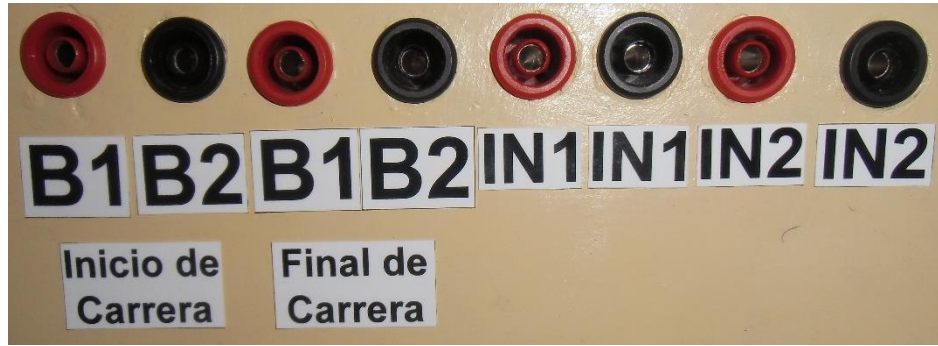
Figura 4-49 Borneras utilizadas para conexión de sensores y relés
