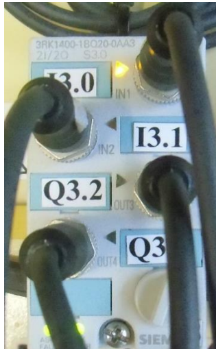
Figura 4-46 Conexiones Eléctricas Físicas de un módulo K45
