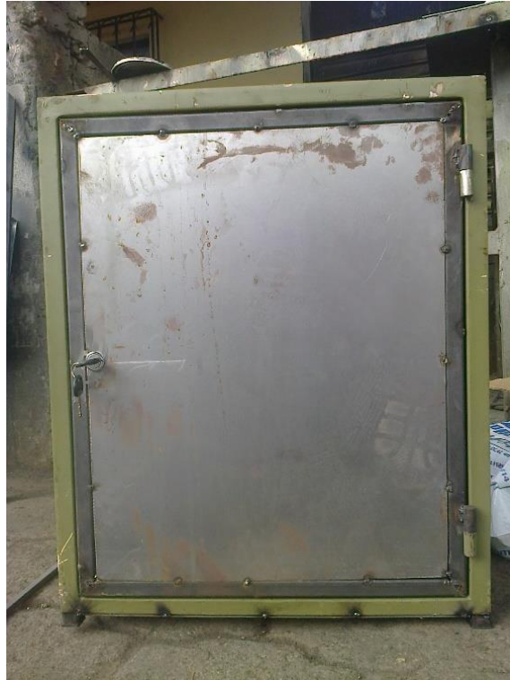
Figura 3-23 Puerta Trasera colocada en el módulo
