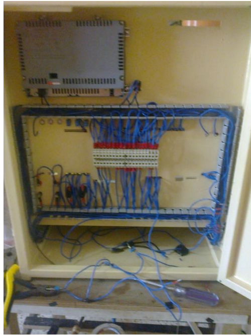
Figura 3-28 Cableado de módulo
