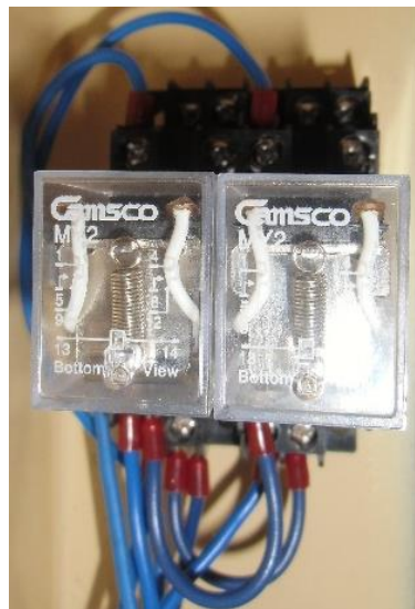
Figura 3-16 Mini relés para activación de sensores
