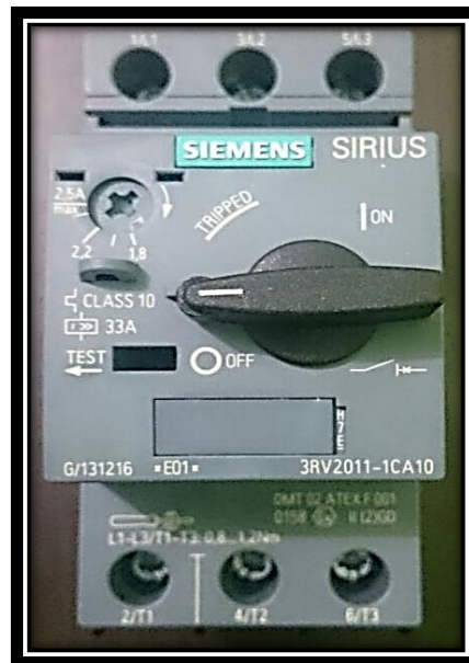
Figura 2.7: Guardamotor Sirius
