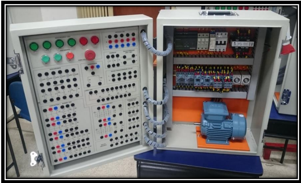
Figura 3.15: Panel Didáctico, panel de control y fuerza
