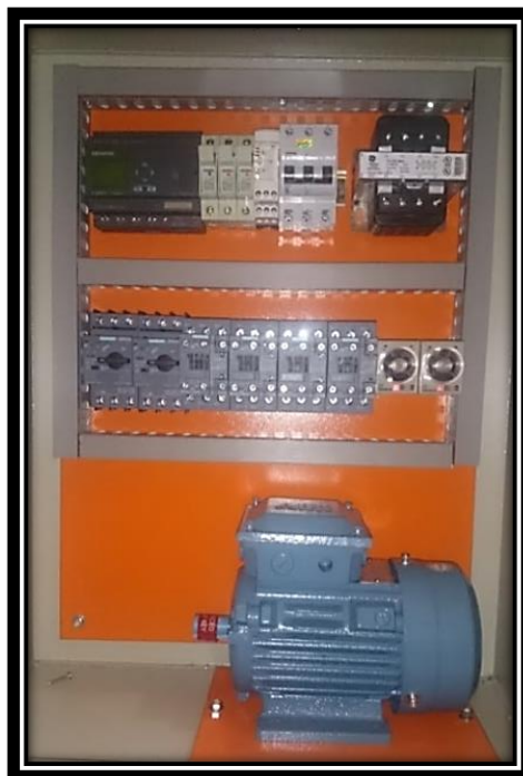
Figura 3.10: Montaje de equipos
