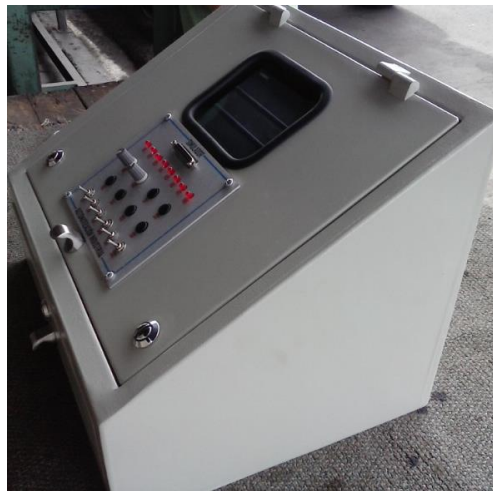
Figura 32. Tablero de Control Automático
