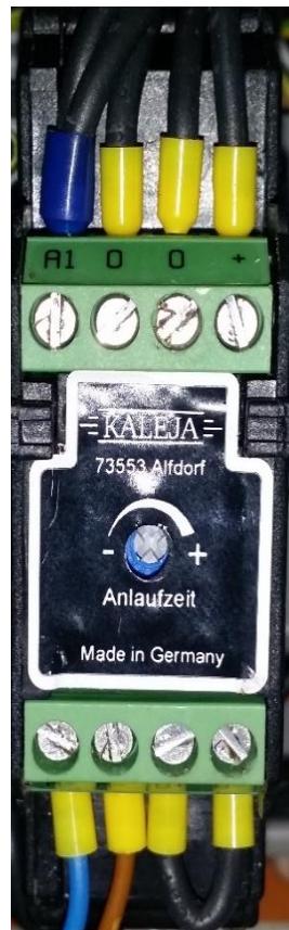
Figura 39. Arrancador suave para bomba dosificadora
