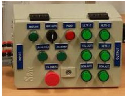
Figura 47. Tablero de Interconexión
