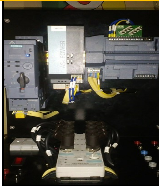
Figura 3.2.14 Montaje de STOP de emergencia y módulo terminado.
