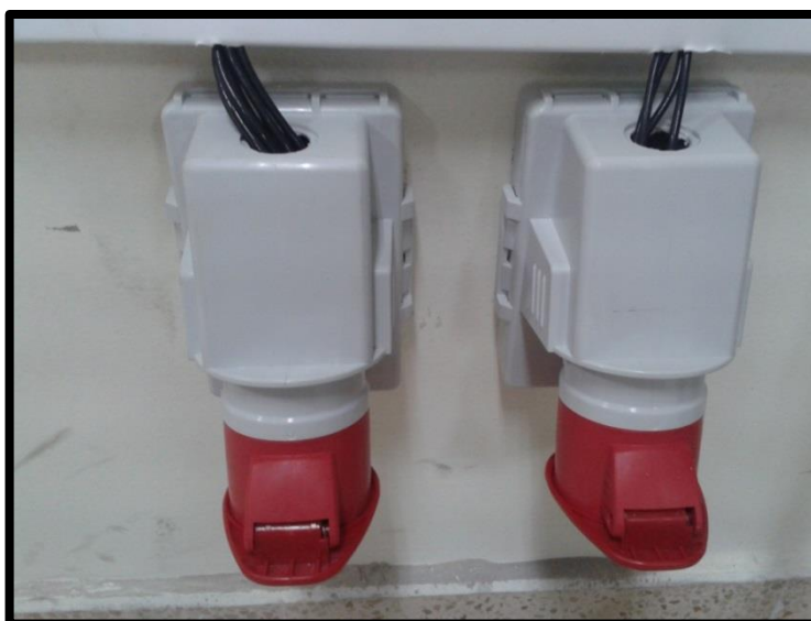
Anexo 4 2 Tomacorrientes trifásicos de 3 Polos + 1 Neutro terminados.
