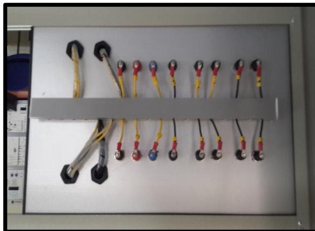
Figura 3.22 Lamina terminada en su parte posterior. Nótese la organización de los cables para una correcta ubicación en un mantenimiento.
