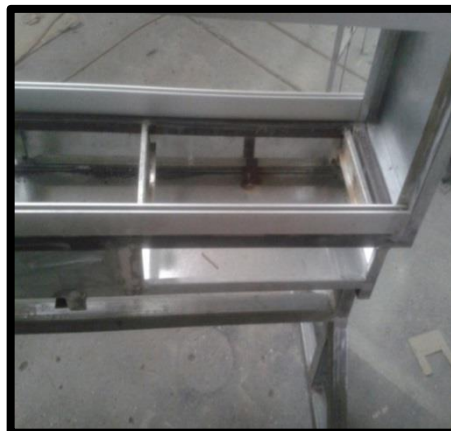
Figura 3.6 Acoplamiento del nuevo cuerpo con la estructura rodante. El contorno del cuerpo sigue siendo de acero motivo por el cual se unió con soldadura eléctrica.
