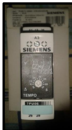
Figura 2.8 Temporizador estrella – delta Siemens. Modelo TPU06.
