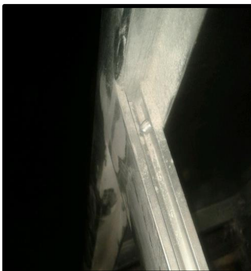
Figura 3.7 Acoplamiento del perfil de aluminio a la estructura lateral del Módulo. Nótese los remaches y corrección de fallas con masilla.
