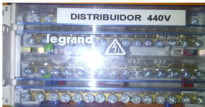
Figura 43: Distribuidor de Tensión marca Legrand. Fuente: Legrand (2014)
