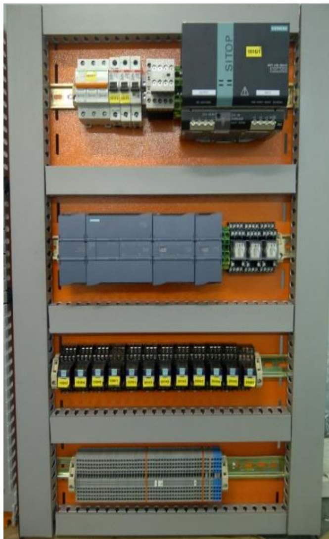
Figura 75: Tablero de Control. Fuente: Autores
