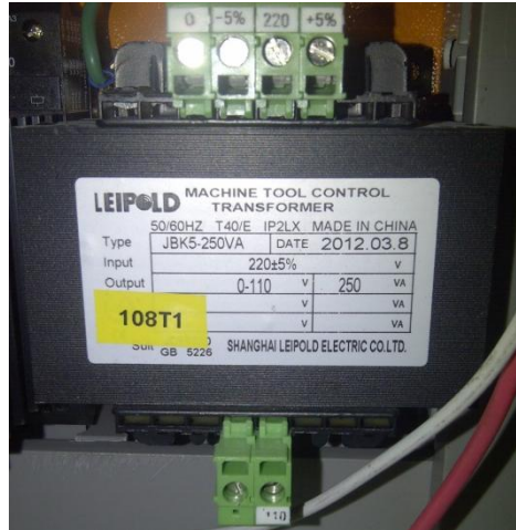
Figura 44: Transformador de Voltaje de 480VAC a 220VAC marca LEIPOLD. Fuente: Leipold (2014)
