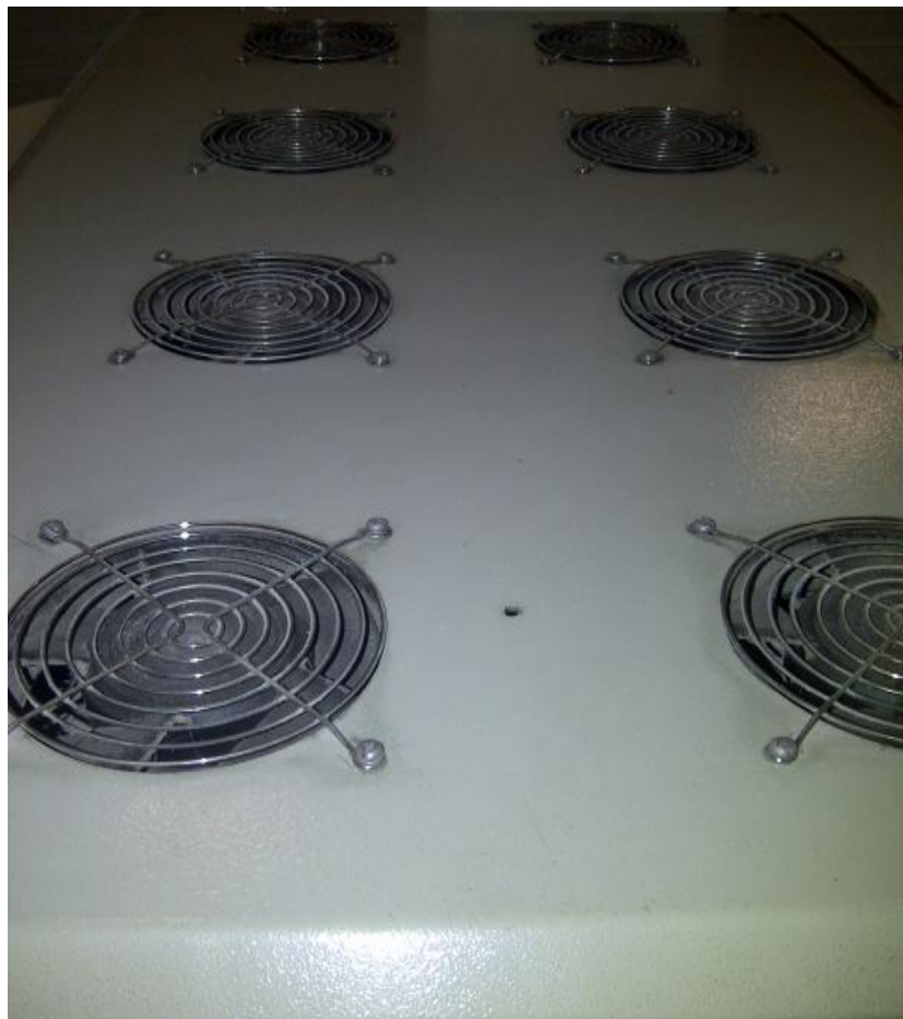
Figura 32: Ventiladores de Enfriamiento Fuente: El Telégrafo (2014)
