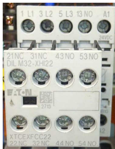
Figura 41: Contactor y bloque de entradas marca EATON Fuente: Eaton (2014)
