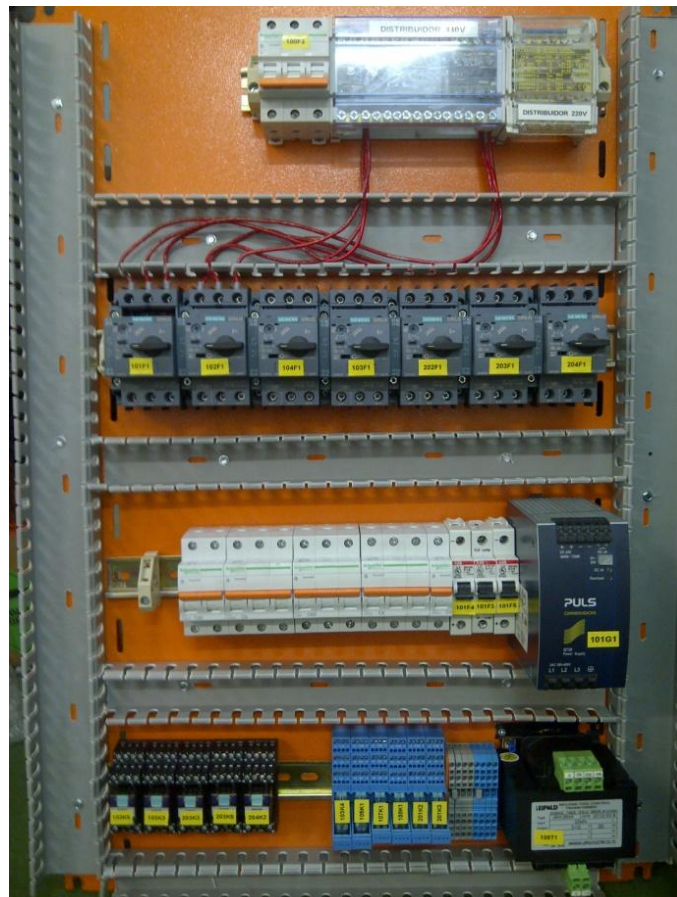
Figura 35: Tablero de Potencia Fuente: Autores
