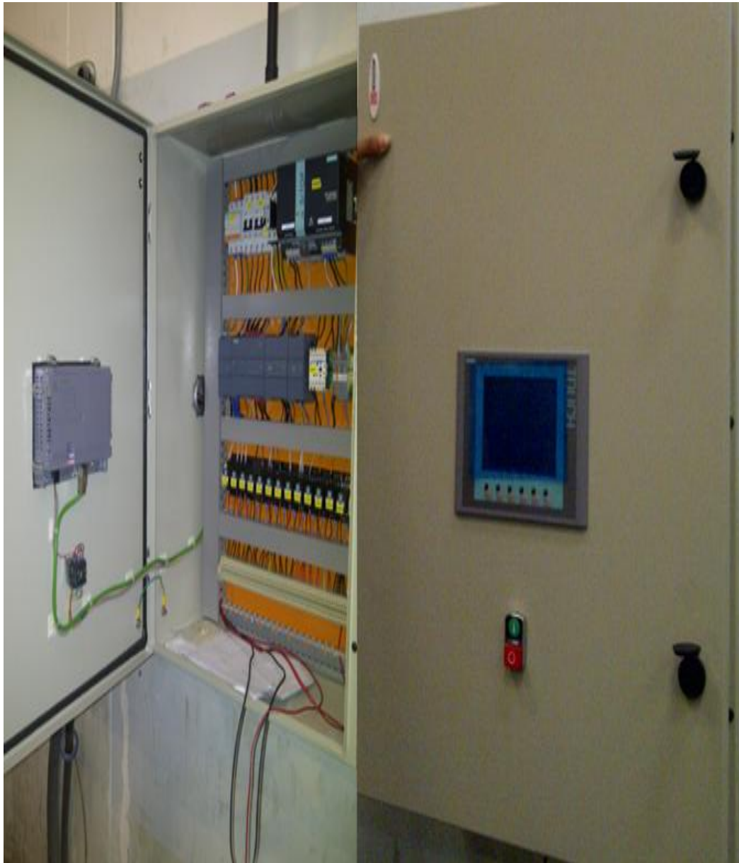
Figura 77: Tablero de Control ubicación del HMI Fuente: Autores
