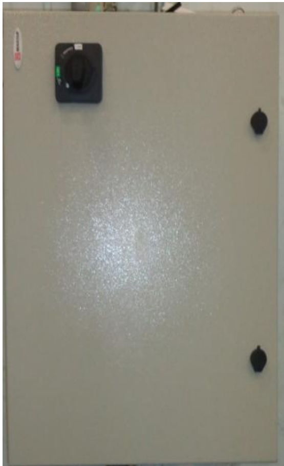
Figura 76: Armario Tablero de Potencia Fuente: Beaucoup (2014)
