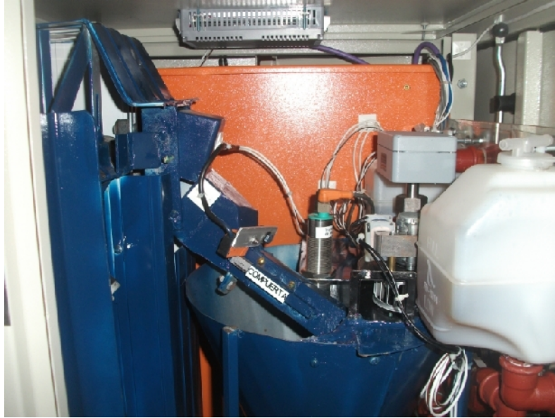
Figura 5.6. Sistema de medición de humedad
