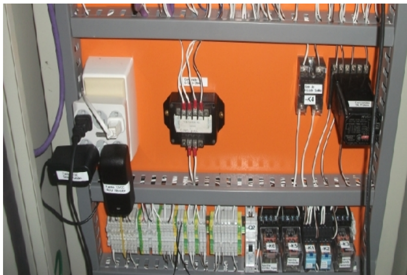
Figura 5.1. Panel eléctrico de banco de pruebas
