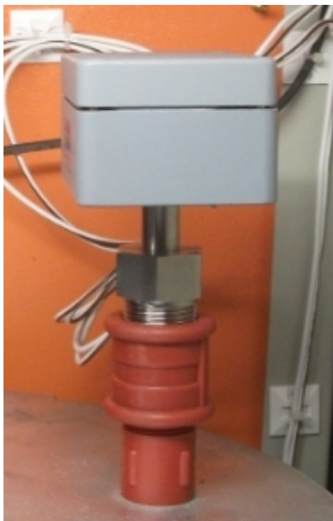
Figura 3.17 Transmisor de humedad colocado en tolva 2
