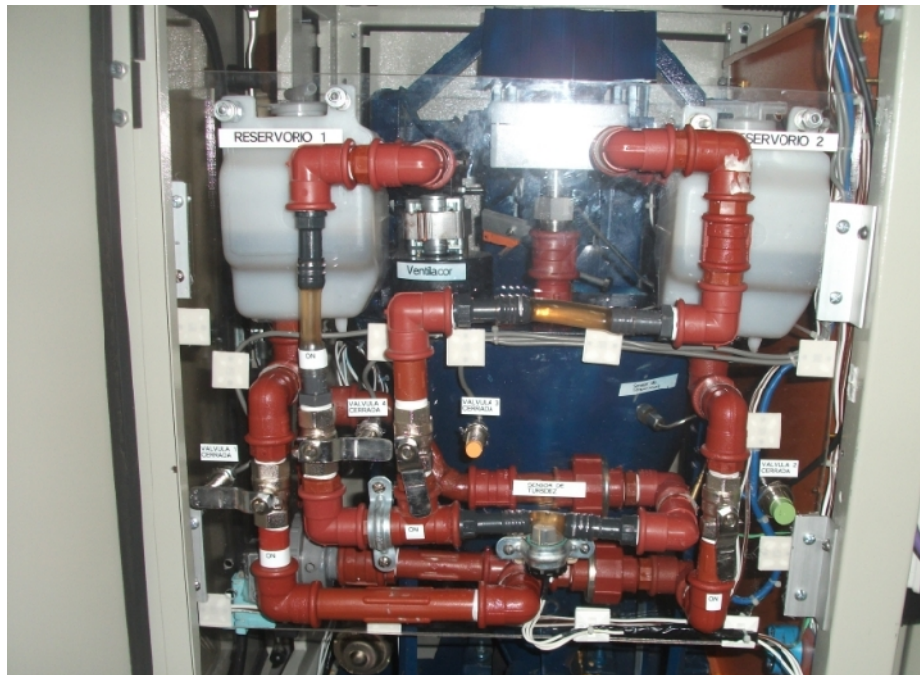
Figura 5.9. Sistema de medición de turbidez
