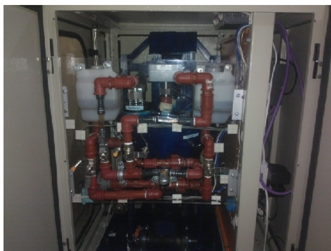
Figura 4.20 Sistema de medición de turbidez
