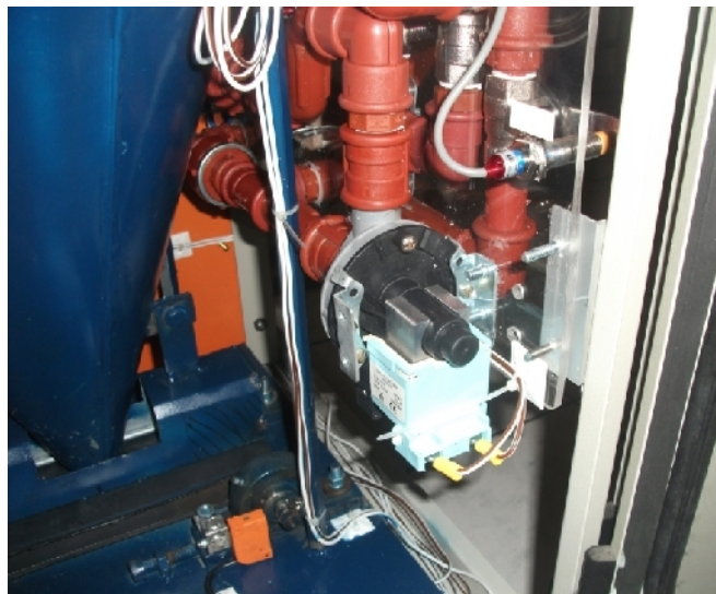
Figura 4.22 Bomba de agua ubicada en banco de prueba.
