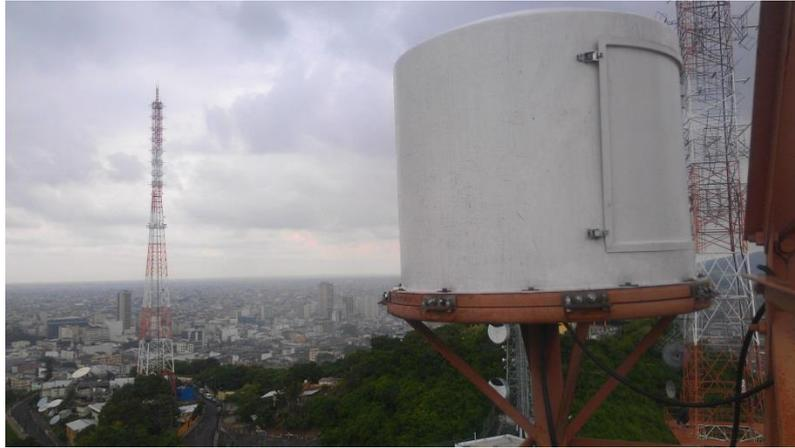
**Figura 4.22** Cúpula que protege al rotor de los fenómenos atmosféricos. **Por:** Autoría propia, (2014).
