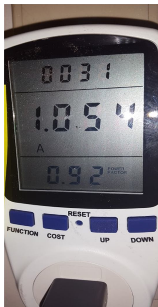
Gráfico 13. Medición de amperios en Servidor controlador de dominio.
