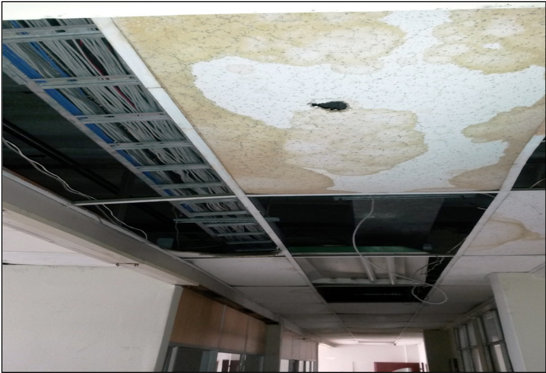
A.4.2.2 Imágenes de las instalaciones – Cielo raso con humedad - Figura 1
