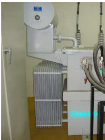
Fotografía 4.2: Cuarto del transformador
