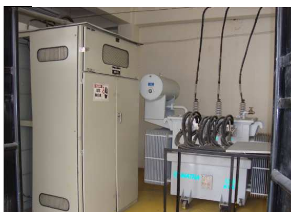
Fotografía 3.5: Cuarto del transformador
