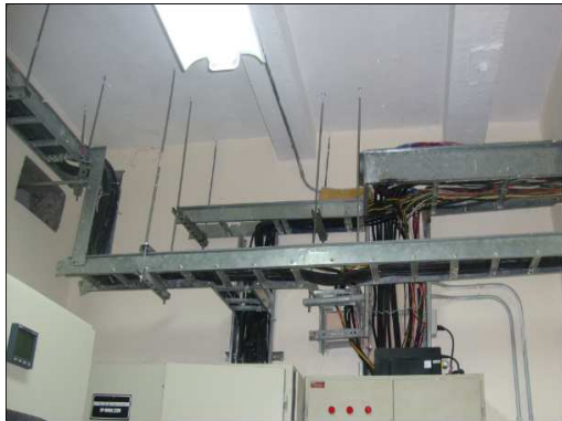
Fotografía 3.25: Bandeja galvanizada en cuarto de tablero principal
