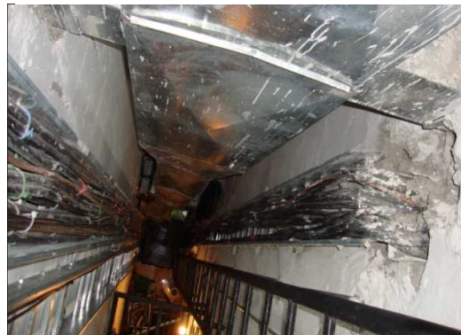
Fotografía 3.27: Parrilla en cuarto de ductos
