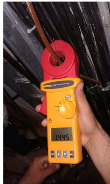
Fotografía 4.6: Mediciones de tierra
