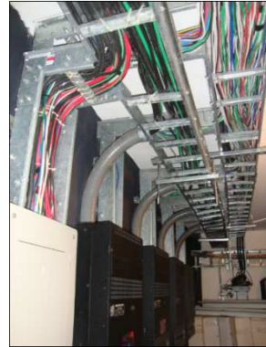
Fotografía 3.24: Bandeja galvanizada en cuarto de control de luces de auditorio principal
