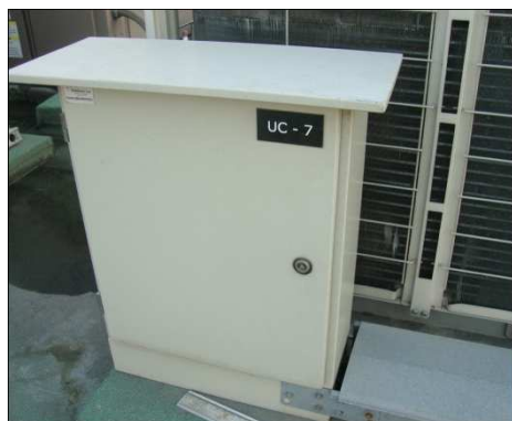
Fotografía 3.21: Tablero TDF7-UC7 vista exterior
