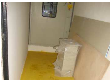
Fotografía 4.3: Celda de protección
