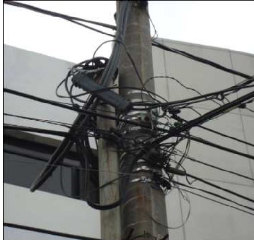
Fotografía 3.3: Poste de acometida aérea principal saturado
