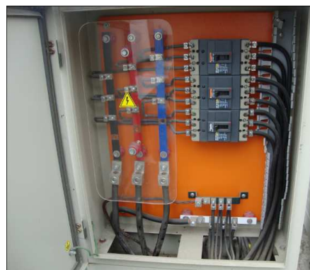
Fotografía 3.20: Tablero TDF7-UC7 vista interior
