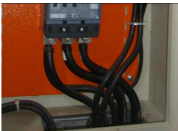
Fotografía 3.1 Acceso en salida de TDF
