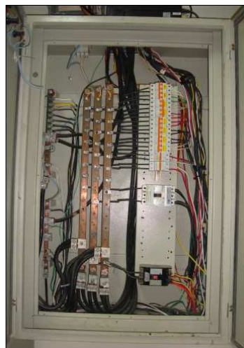
Fotografía 3.15: Tablero TDF3 vista interna
