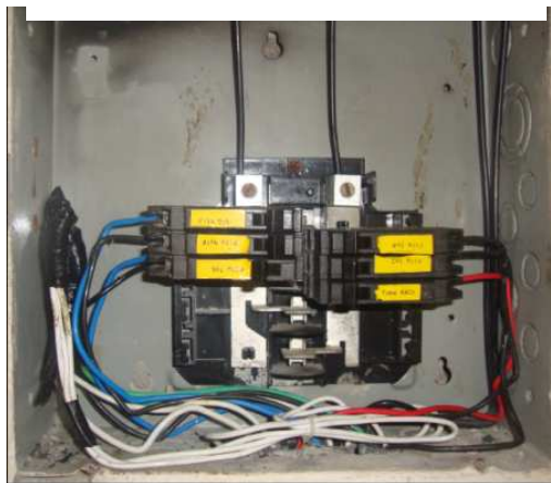
Fotografía 3.6: Tablero de distribución laboratorio 1 – piso 1
