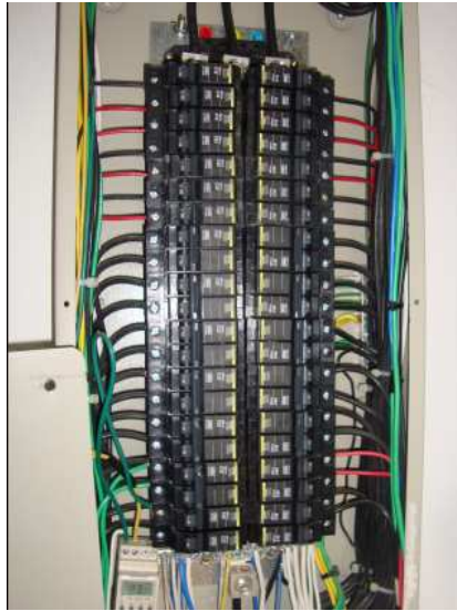
Fotografía 3.7: Tablero de distribución PD2-04 – Piso 2
