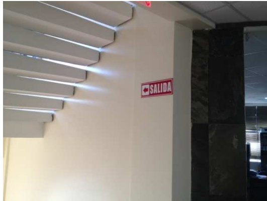
Fotografía 4.9: Ruta de evacuación - escaleras en bloque D
