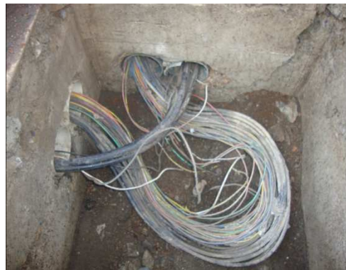
Fotografía 3.30: Cables en interior de caja de paso
