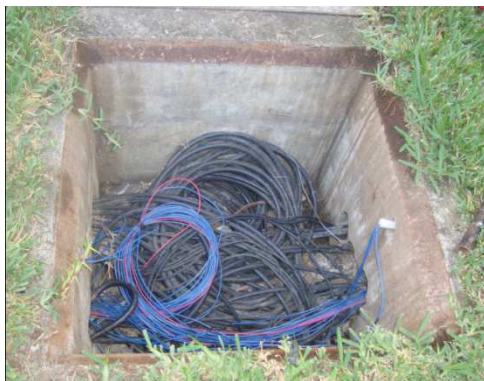
Fotografía 3.31: Caja exterior bloque central
