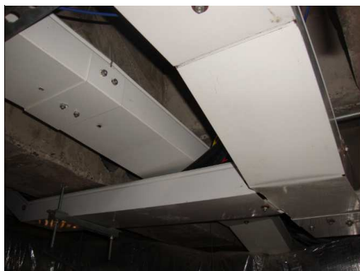
Fotografía 3.23: Bandeja eléctrica piso 1
