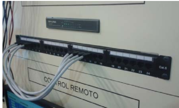
Figura98Switch de comunicación y patch panel
