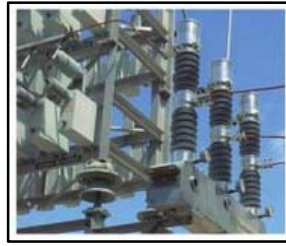
Figura10 Interruptor automático
