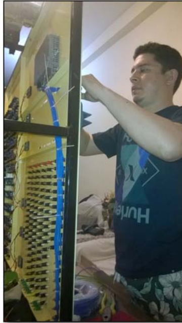
Figura50 Cableado de PLC S71200
