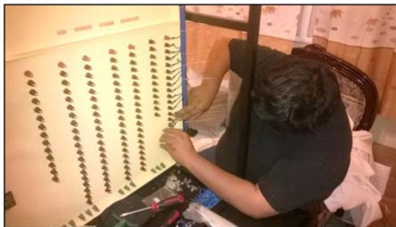
Figura51 Conexión del PLC a borneras
