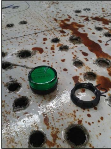
Figura30 Verificación de perforaciones
