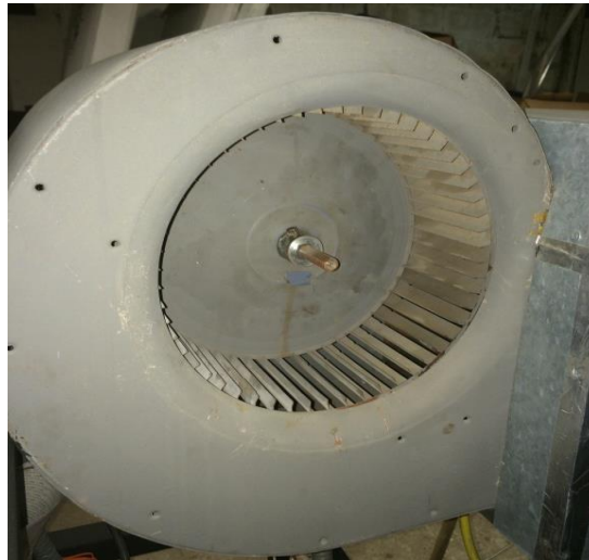
Figura. 3.4. Ventilador Centrífugo Fuente: Los autores
