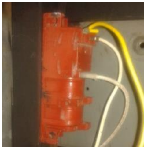
Figura 3.11. Unidad de encendido. Fuente: Los autores
