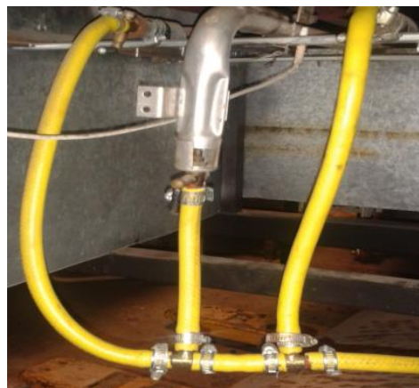
Figura 5.5 Conexión a los quemadores Fuente: Los Autores
