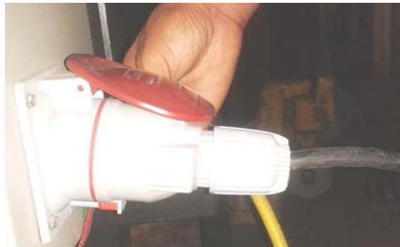
Figura 5.6. Alimentación eléctrica Fuente: Los Autores
