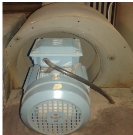
Figura. 3.3 Motor Trifásico. Fuente: Los autores
