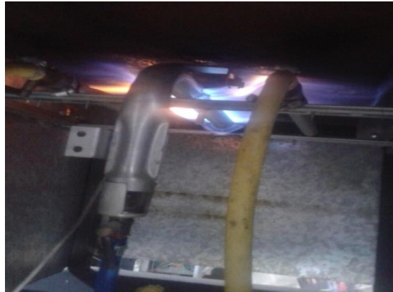
Figura. 3.6. Quemadores tipo Flauta Fuente: Los autores
