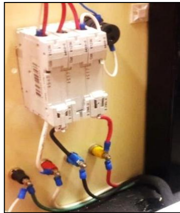
Ilustración 63 Vista Posterior Disyuntor Principal
