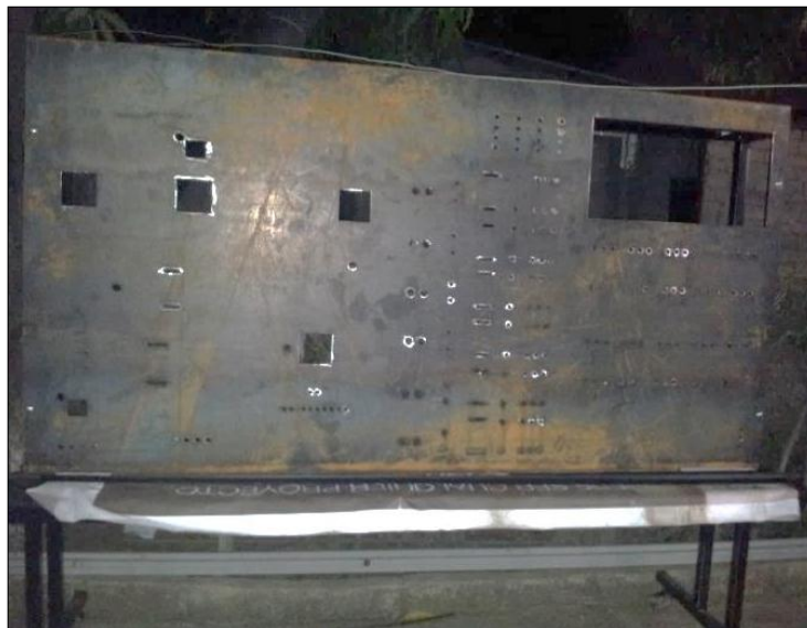
Ilustración 47 Elaboración de perforaciones.
