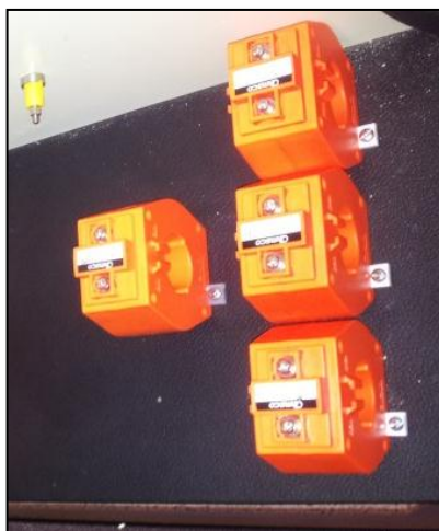
Ilustración 37 Transformadores de Corriente 30/5A
