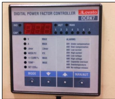
Ilustración 33 Equipo Controlador de Factor de Potencia
