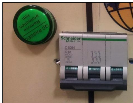
Ilustración 64 Vista Frontal de Disyuntor Principal
