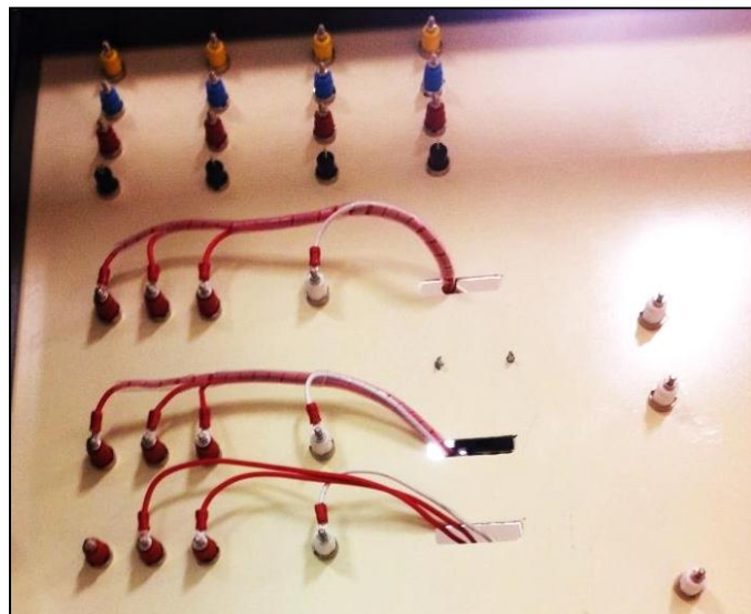
Ilustración 58 Cableado y conexión bornes tipo banana.
