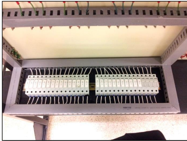
Ilustración 57 Cableado y conexión de Capacitores.
