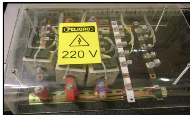
Figura 39 Barras de fuerza (módulo)
