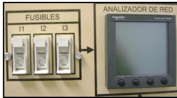
Figura 32 Analizador de red (módulo)
