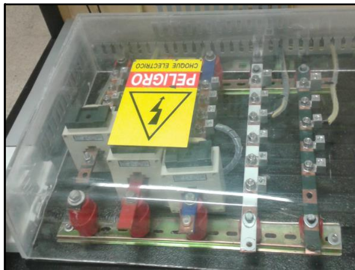
Figura 28 Instalación de barras de fuerza
