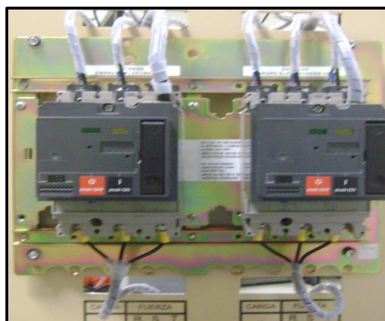
Figura 38 Breakers motorizados (módulo)
