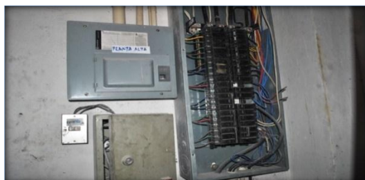
FIGURA 11: ÁREA DE TRANSFORMADOR
